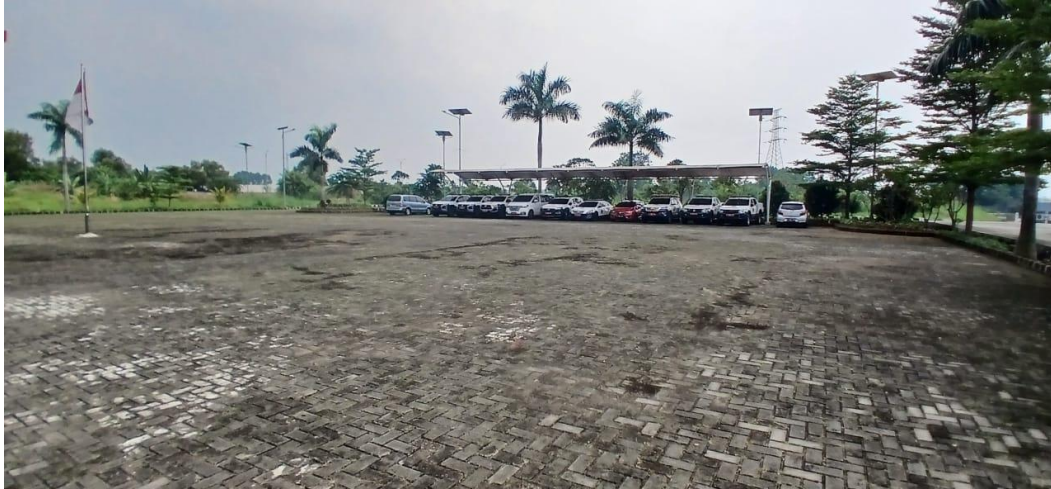
Lokasi A2 Paving block (lahan parkir) Luas 3.255 m 2
