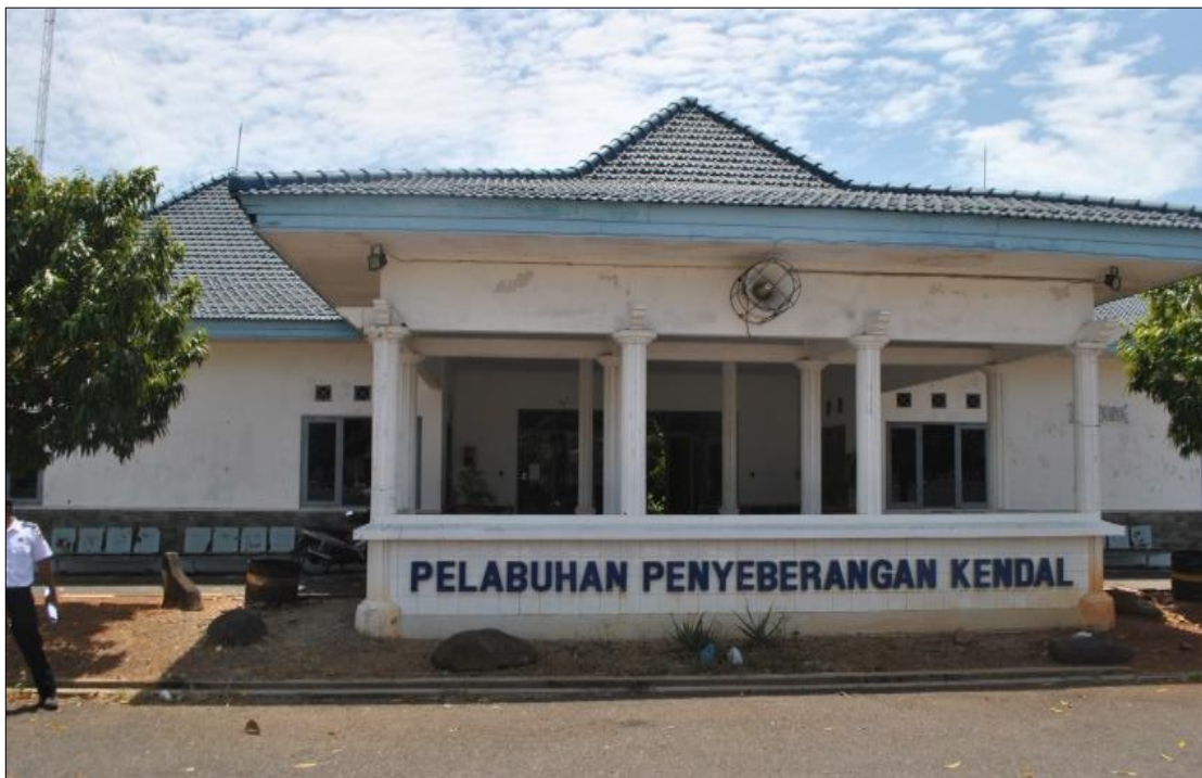
Gambar 1.40 Pelabuhan Penyeberangan Kendal
