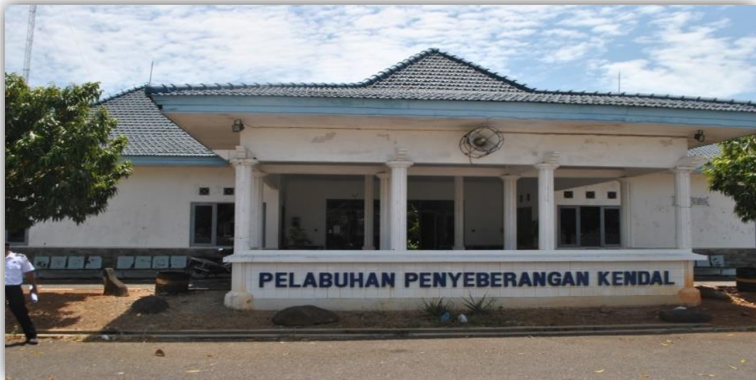
Gambar 1.40 Pelabuhan Penyeberangan Kendal
